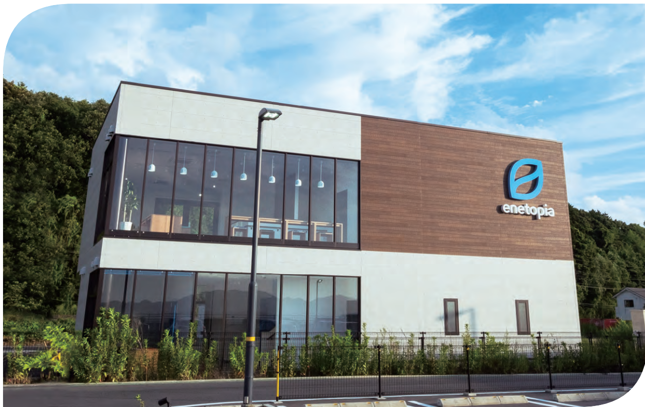
宍道湖(国道9号線)側から見た外観
